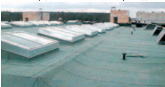
Рис. 8. Покрытие над спортзалом после завершения ремонтно-восстановительных работ по разгрузке и усилению ферм, ремонту кровли и модернизации фонарей
