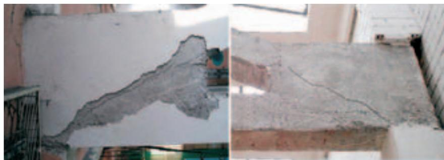
Рис. 3. Характерные трещины в опорном узле фермы
