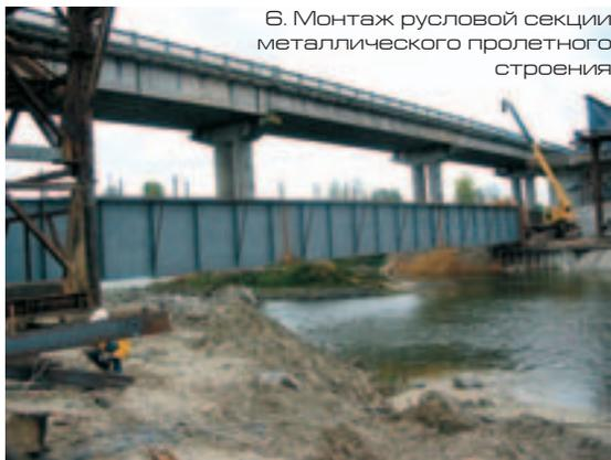
имеет схему 33+65,8+75,9+65,8+33 м. Общая его длина 275,6 м, габарит — 11,6 м с односторонним метровым тротуаром для пешеходов. Береговые и промежуточные опоры моста решены в монолитном исполнении на буронабивных столбах  $\varnothing 1,5$  м, как наиболее эффективном основании глубокого заложения.
