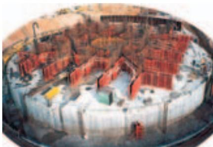
Рис. 3. Возведение монолитных стен подвала
