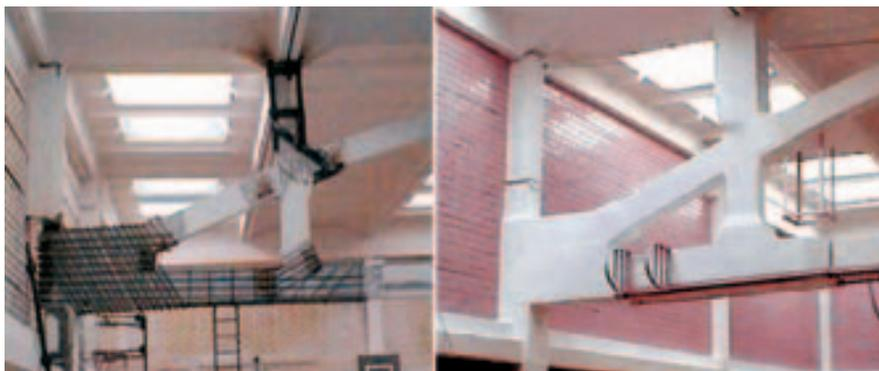
Рис. 7. Усиление опорного узла фермы преднапряженной армоцементной рубашкой (слева — в процессе установки дополнительной арматуры, справа — после завершения торкретирования напрягающимся составом)
