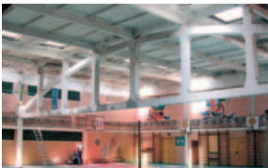
Рис. 1. Общий вид спортзала школ, возведенных по проекту 222-1-475.86 с применением железобетонных ферм пролетом 24 м серии 1.463.1-3/87
