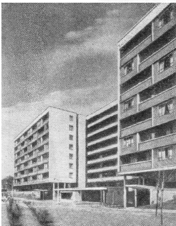
Рис. 216. Галерейный восьмизэтажный дом из трех блоков, соединенных двумя узлами вертикальных коммуникаций (Англия)
