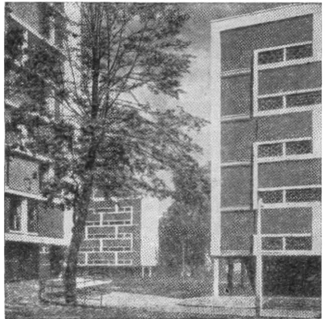
Рис. 321. Вид застройки со стороны двора в микрорайоне Паддингтон, Англия
