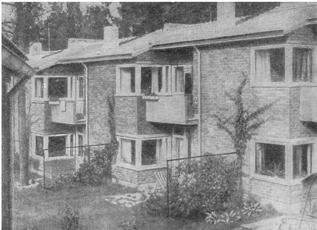
Рис. 109. Двухэтажный блокированный дом (Финляндия) Ступенчатое смещение блоков по горизонтали и по вертикали позволяет организовать удобные изолированные площадки
