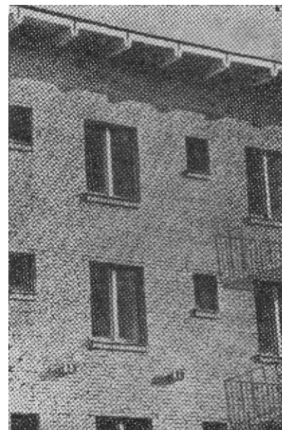
Рис. 235. Фрагмент фасада дома с несущими кирпичными стенами (Новые Черемушки, Москва)
