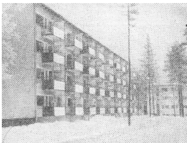
Рис. 243. Примеры ограждения балконов из листового алюминия и цветного брезента (Финляндия)
