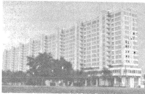
52. Шумозащитный жилой дом со светлым коридором и с полной защитой от шума всех жилых помещений для южных, восточных и западных
