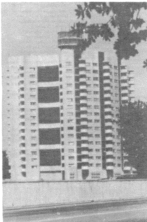
37. Галерейные жилые дома с галерей в центре дома. Проветривание и освещение галереи через террасы (см. с. 350)
